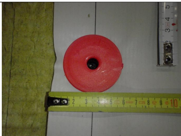
Фото 4 Расстояние между крепежом и краем полотна гидроизоляционной мембраны
