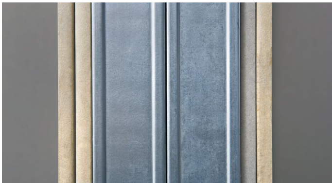
Рис. 7. Обшивка второй стороны перегородки листами ГКЛ
