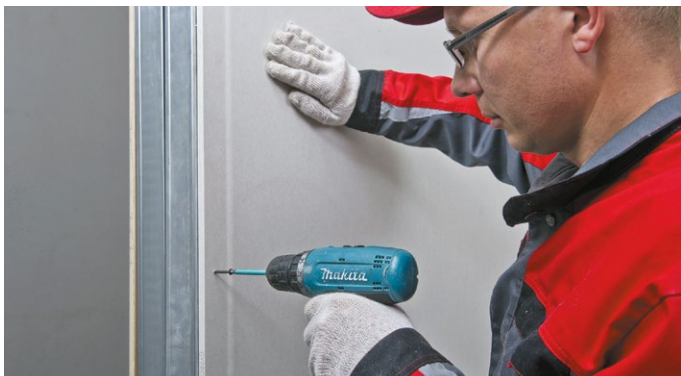
Рис. 13. Обшивка стен листами ГКЛ
