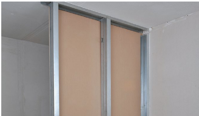
Рис. 5. Обшивка первой стороны перегородки листами ГКЛ
