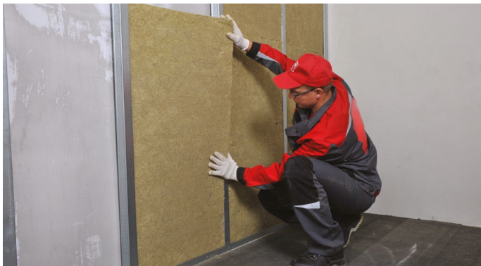
Рис. 12. Монтаж тепло-, звукоизоляционных плит
