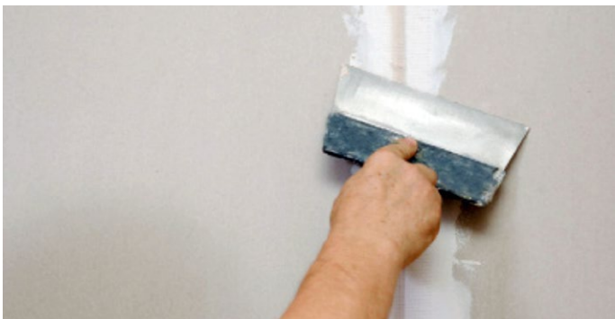
Рис. 8. Заделка швов
