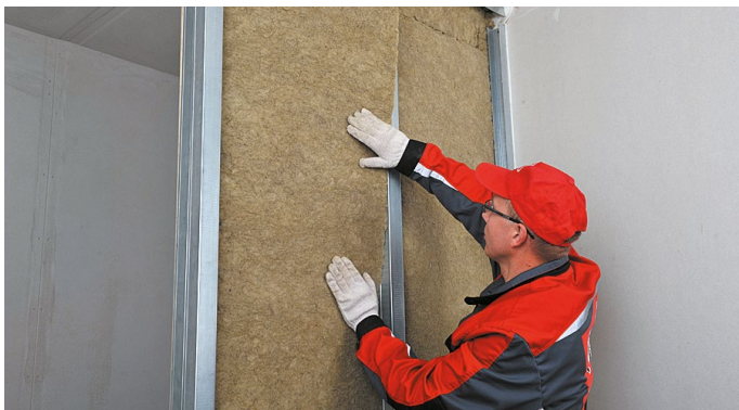
Рис. 6. Монтаж тепло-, звукоизоляционных плит
