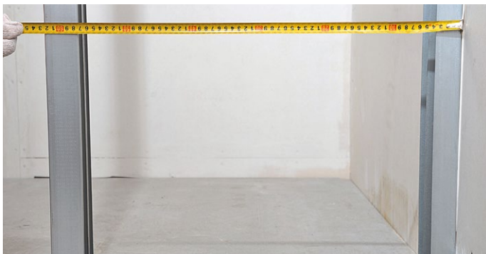
Рис. 4. Установка стоечного профиля
