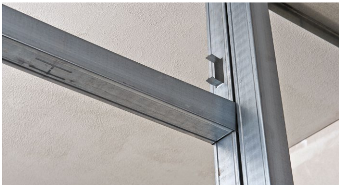
Рис. 4. Установка стоечного профиля (продолжение)
