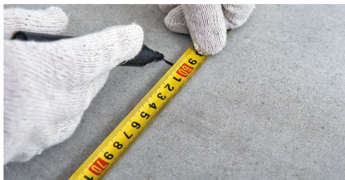
Рис. 2. Разметка основания
