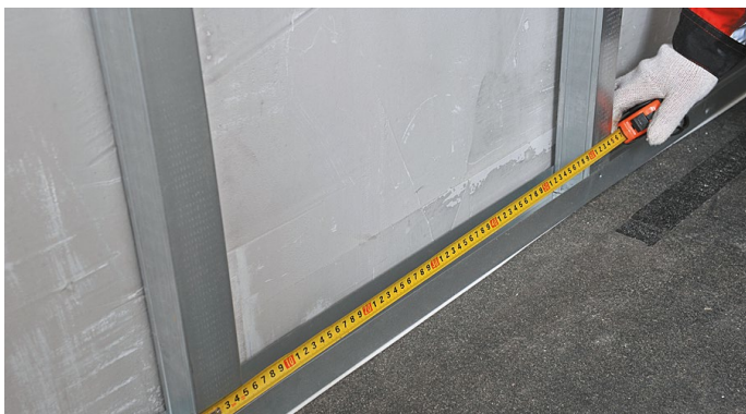
Рис. 11. Установка направляющего и стоечного профилей
