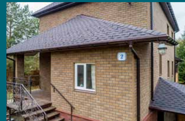
Объект «ПОСЛЕ». Коллекция КИРПИЧ, цвета Песчаный кирпич и Терракотовый кирпич
