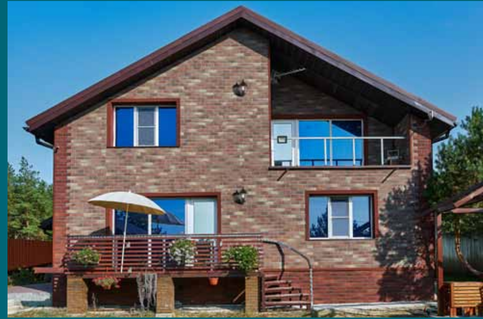
Объект «ПОСЛЕ». Коллекция КИРПИЧ, цвет Английский кирпич
